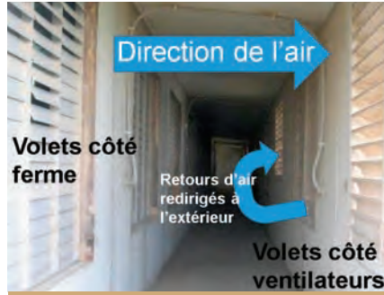
Image 4 : Banc de ventilateurs
