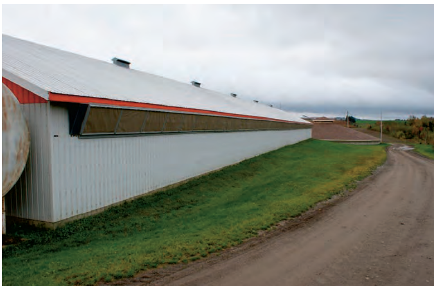
Image 5 : Filtration d'air avec filtres antimicrobiens (entrée d'air latérale).
