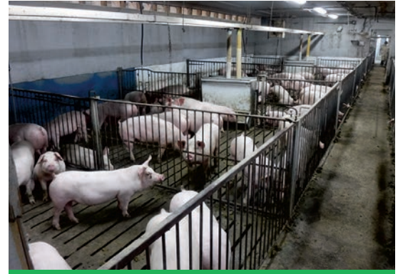
Plancher entièrement latté.
