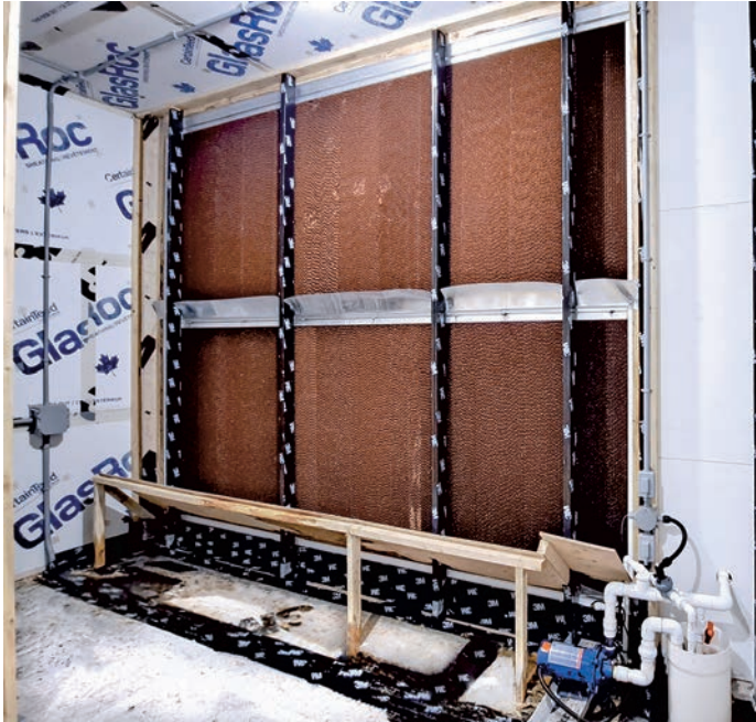
Figure 2. Rideau d'évaporation d'eau afin de refroidir l'air ambiant
