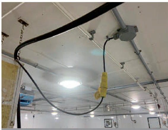
L'installation de prise bien étanche éloigne les risques d'incendie attribuables à la corrosion de l'équipement.
