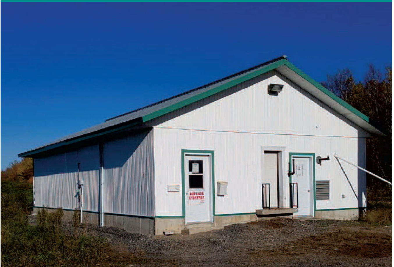
Ce bâtiment abrite une quarantaine munie d'une génératrice.
