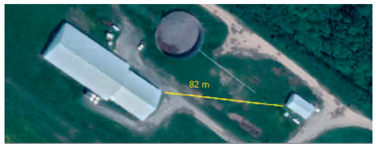
Une distance minimale de 100 m est souhaitable entre la quarantaine et les autres bâtiments d'élevage.
