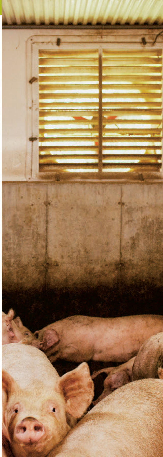
Des ventilateurs de 14 pouces ont été installés dans 3 de leur 4 engraissements ventilés conventionnellement. Le quatrième engraissement est en ventilation naturelle avec 4 pieds d'ouverture de chaque côté pour apporter un meilleur volume d'air.
